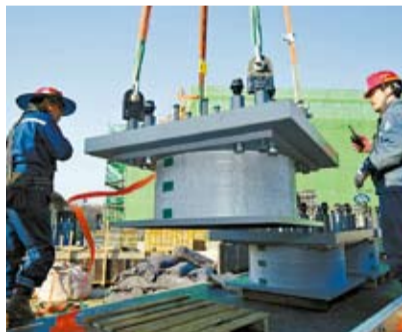
면진 장치를 건물 내부에 설치하고 있는 모습(왼쪽). 700일만 공사를 성공적으로 마친 현장 직원들.
