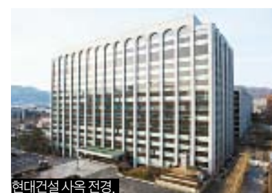
현대건설 사옥 전경
