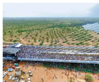
이 1.4km(700m 사장교, 400m 접속교, 300m 접속 도로), 주탑 높이 80m, 주경간 350m로, 인도 최대 규모다. PSC(Parallel Strand Cable) 타입의 케
